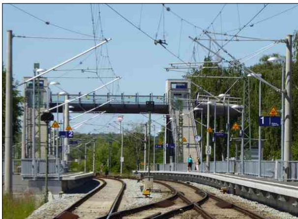
Abbildung 2: Im Frühjahr 2015 wurden die Aufzüge des am 14.12.2014 eröffneten Bahnhofs Lübeck-Dänischburg IKEA fertiggestellt.
