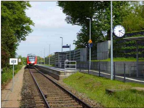
Abbildung 1: Am 4.1.2015 wurden fünf neue Stationen zwischen Rendsburg und Kiel Hbf in Betrieb genommen. Achterwehr ist eine davon.
