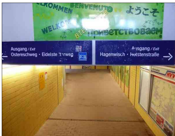
Abbildung 26: Die Wegeleitungsschilder im südlichen Tunnel von Halstenbek sind abgenutzt.
