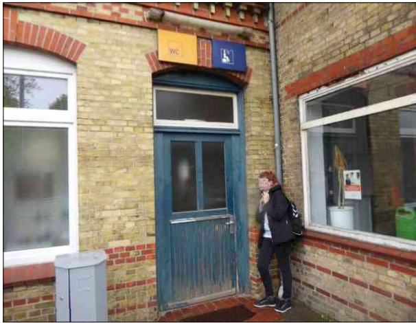
Abbildung 34: Der Warterraum in Sörup war gesperrt. Daher stand für die Fahrgäste am Bahnhof kein Wetterschutz zur Verfügung.
