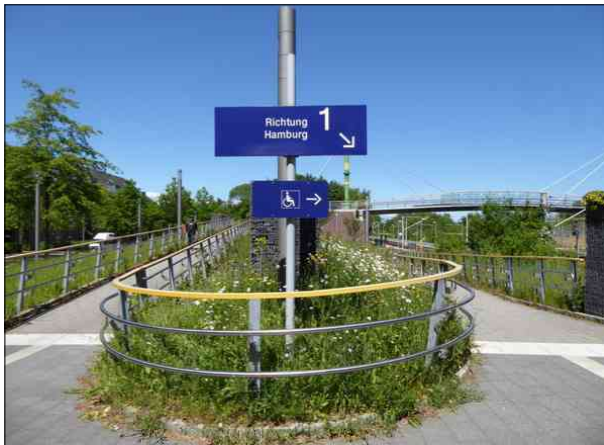
Abbildung 53: Die Wegeleitung in Ahrensburg-Gartenholz ist nicht optimal. An dieser Stelle wäre ein Hinweis auf den Weg zu Gleis 2 über die linke Rampe nicht nur für Rollstuhlfahrer sinnvoll.
