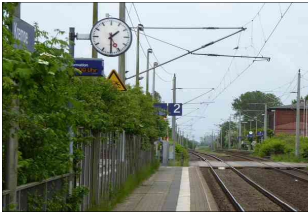
Abbildung 19: Die Uhr an Gleis 2 in Krempe war einseitig defekt. Leider war der die Uhrzeit korrekt anzeigende DSA zugewachsen.
