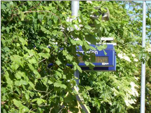
Abbildung 17: In Bad Segeberg war der DSA an Gleis 2 nicht freigeschnitten.
