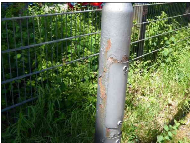
Abbildung 47: Einige Lichtmasten in Bargtheide sind angerostet.
