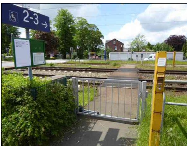
Abbildung 57: Der monatelang defekte barrierefreie Zugang zum Mittelbahnsteig in Wrist wurde instand gesetzt.
