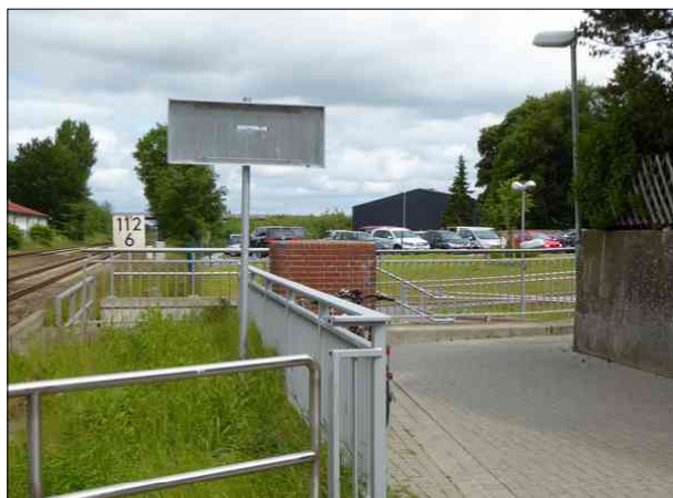
Abbildung 25: In Meldorf fehlte das Wegeleitungsschild am Ausgang von Gleis 2.
