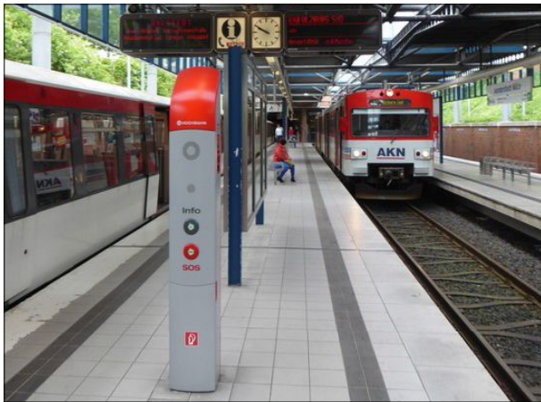
Abbildung 52: Im Bahnhof Norderstedt Mitte, für den die Hamburger Hochbahn zuständig ist, wurden neue Notruf- und Informationssäulen aufgestellt.
