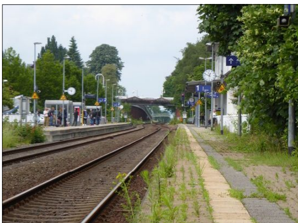
Abbildung 6: Der Hausbahnsteig in Eutin war im südlichen Bereich stark verkrautet.
