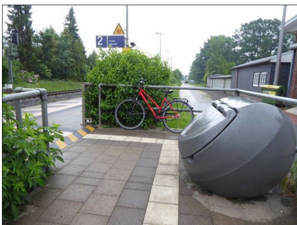
Abbildung 51: Nach wie vor ragte im Zugang zu Gleis 2 in Dauenhof eine Streugutbox auf den Blindenleitstreifen.
