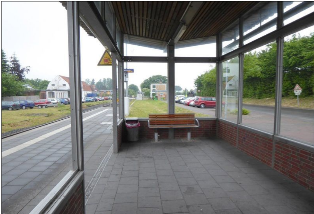
Lensahn: Haltepunkt an der Strecke Lübeck - Puttgarden. Nur noch eine der großen Scheiben in der Wartehalle ist vorhanden. Von den oberen Scheiben sind einzelne beschädigt.
