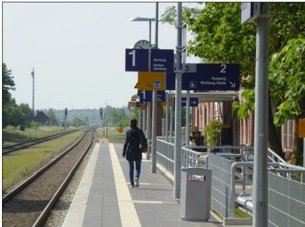
Abbildung 25: Auswahl und Platzierung der Schilder am neuen Hausbahnsteig in Meldorf tragen nicht zur Übersichtlichkeit bei. Auch die Uhr wird teilweise verdeckt.
