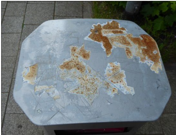
Abbildung 13: Die Abfallbehälter in Einfeld weisen mittlerweile größere Lackschäden auf.
