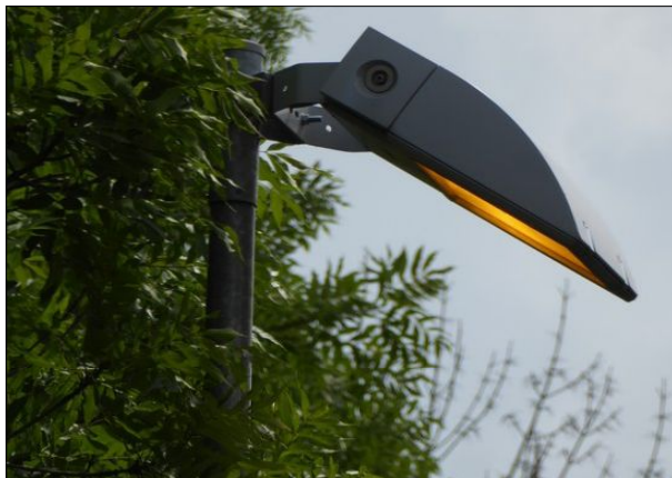
Abbildung 48: Seit drei Jahren ist in Bad Malente-Gremsmühlen eine Leuchte an Gleis 1 nicht auf den Bahnsteig sondern zum benachbarten Kurpark ausgerichtet.
