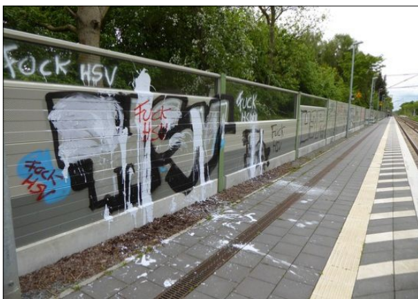
Abbildung 24: Bis zur Errichtung der Lärmschutzwand war das Erscheinungsbild des erneuerten Haltepunkts in Prisdorf gut. Das Bauwerk selbst und besonders die folgenden Schmierereien beeinträchtigen den Wartekomfort deutlich.
