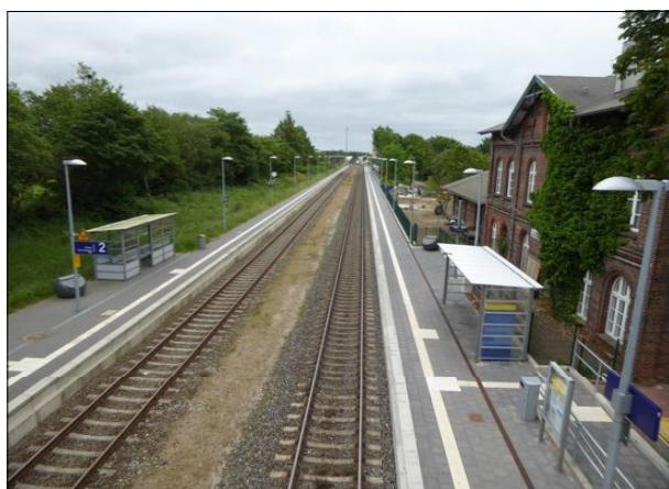
Abbildung 2: Am Hausbahnsteig in Lunden wurde im Zuge der Erneuerung auch ein Unterstand errichtet. Im Gegensatz zum Bahnsteig an Gleis 2 wurde jedoch kein Zugang zum Bahnübergang hergestellt.
