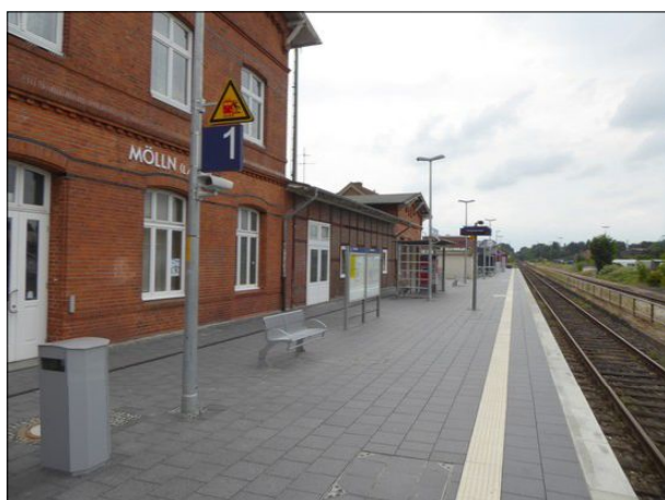
Abbildung 3: Auch in Mölln wurde die im Winter begonnene Bahnsteigerneuerung abgeschlossen.
