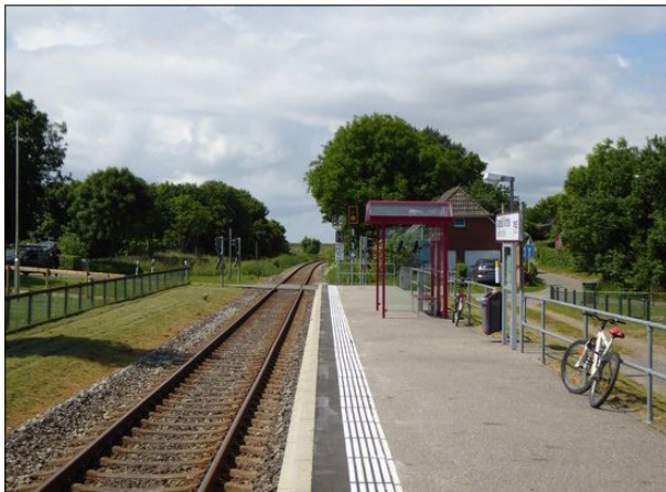
Abbildung 49: Nach dem Auffüllen von Absackungen wurde in Dagebüll Kirche im Frühjahr auch der Blindenleitstreifen wieder hergestellt.
