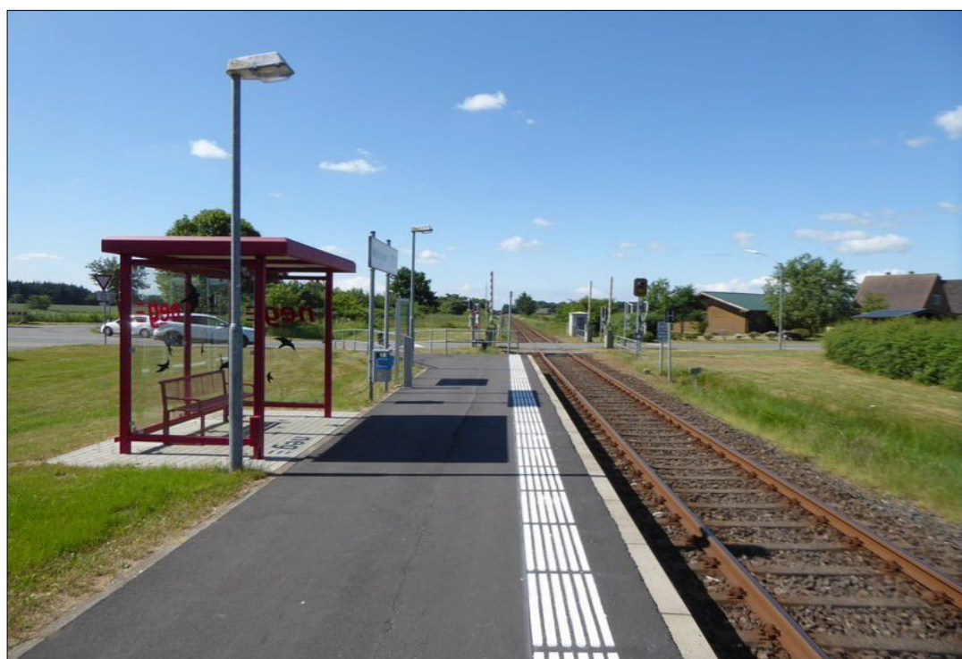
Uphusum: Haltepunkt an der Strecke Niebüll - Tønder.
