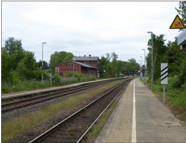
Abbildung 4: Die bereichsweise großen Absackungen auf den Bahnsteigen in Friedrichstadt wurden beseitigt.
