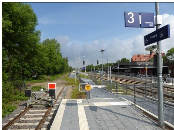
Abbildung 1: In Eckernförde wurden die Bahnsteige erneuert. Durch die gleichzeitige Erhöhung ist der Einstieg in die Triebwagen nun niveaugleich möglich.
